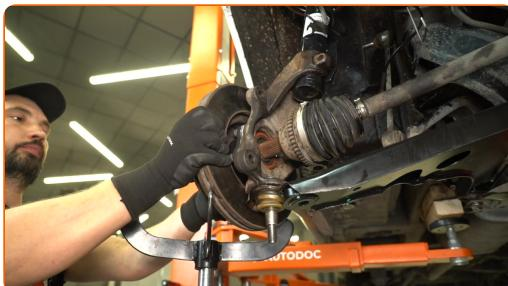
Výměna: kulový čep ramene - FORD Transit Mk5 Valník/Podvozek (V184, V185). Tip:
