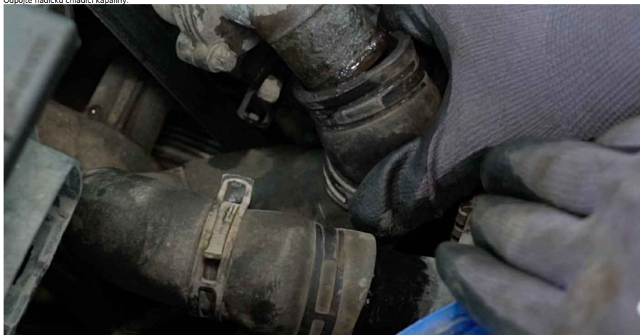
Výměna: termostatu - VAUXHALL Astra Mk1 Combi. AUTODOC doporučuje: • Pozor! Z potrubí pro chladicí kapalinu a z krytu termostatu může vytékat chladivo.
