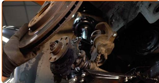
Výměna: brzdového kotouče - VAUXHALL Tigra TwinTop (X04). Doporučují odborníci z AUTODOC:
