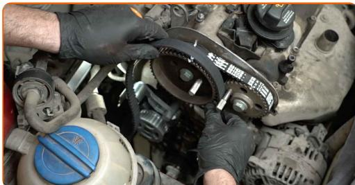
Výměna: vodní čerpadlo + sada rozvodového řemene - VW Golf V Variant (1K5). AUTODOC doporučuje:
